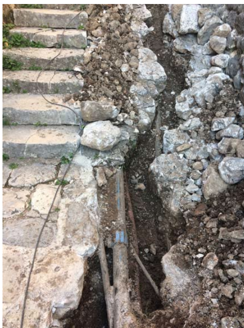
Slika 8.2. Postojeće instalacije u ručno otkopanom rovu
