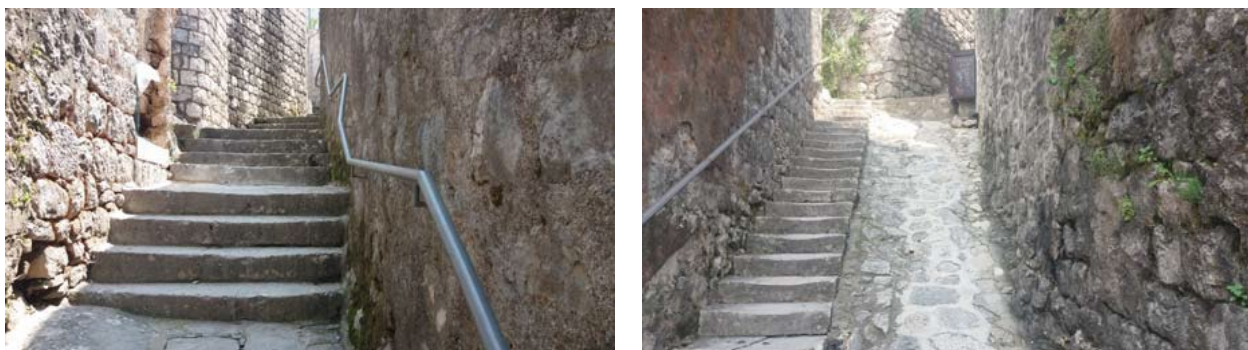
Slika 8.1. Tipične ulice punog stepenišnog profila (lijevo) i kombinovanog stepenišnog profila i plitkog kanala za odvod atmosfere vode (desno)
